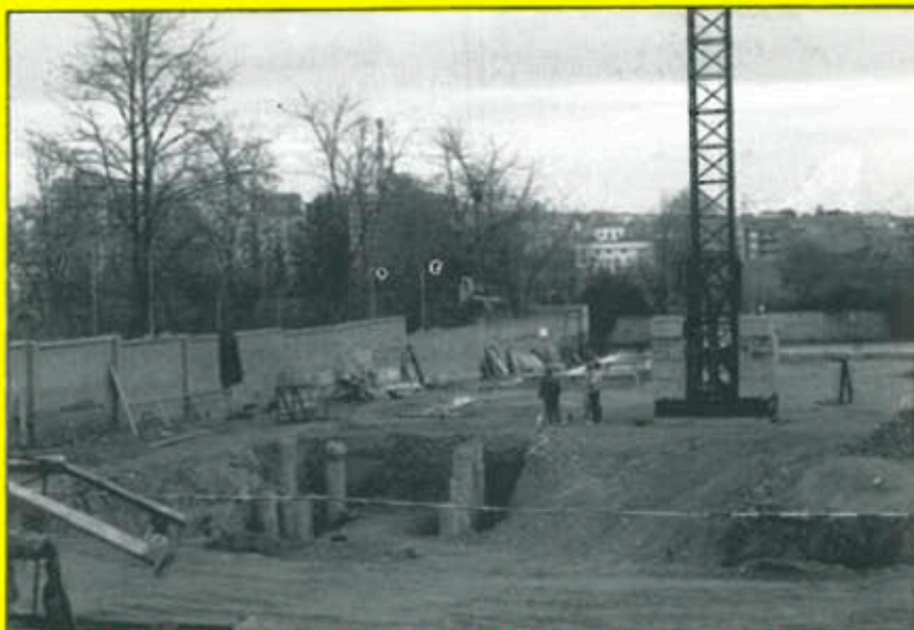
Vista general de l'estat de les obres del Teatre Municipal de Balaguer
