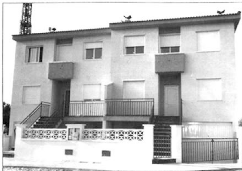
Construccions Justo Flores, S.L. VALLFOGONA - OBRA HOSTAL NOU
