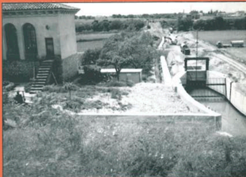
Millores en un tram del canal auxiliar del canal d'Urgell
