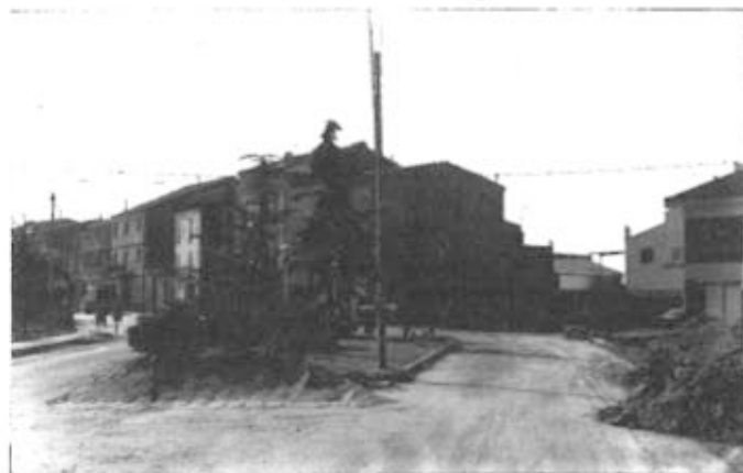
L'entrada a Vallfogona es troba en obres
