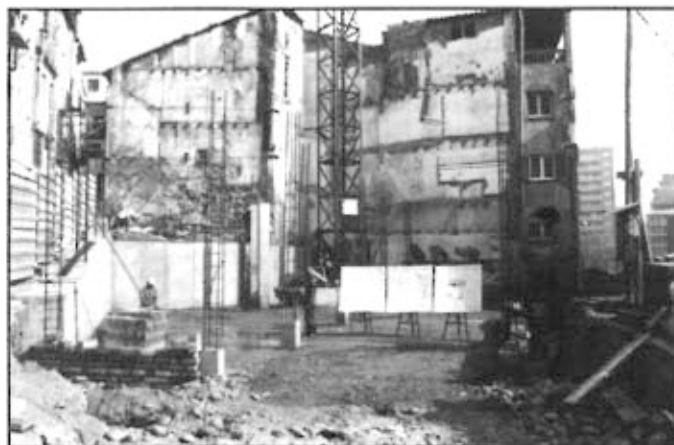
Construcció de vivendes socials a la plaça Sant Salvador
