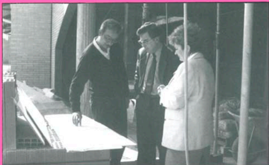
Teresa Ribes i Josep Borràs en la visita a les obres de la nova Residència Geriàtrica
