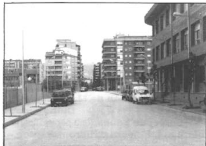
El nou tram del carrer Barcelona ja finalitzat
