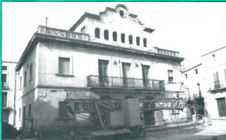
Ja han començat les obres de remodelació a l'Ajuntament de Bellcaire
