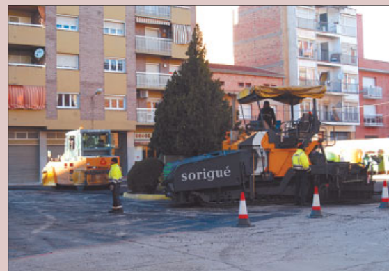
Màquines pavimentant carrers de Balaguer
