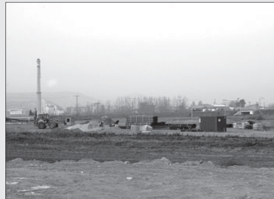
Obres d'ampliació de la zona industrial
