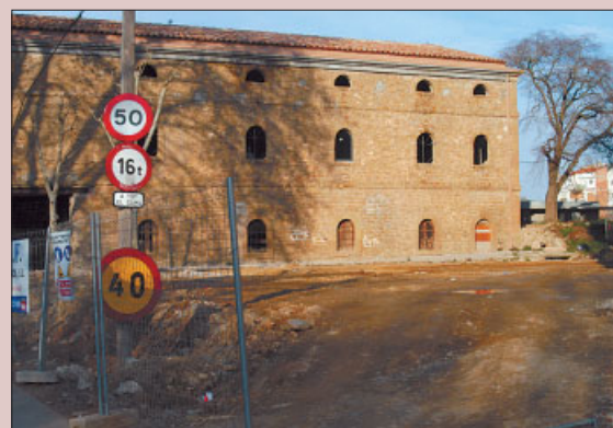
Urbanització de la Plaça Molí de l'Esquerrà
