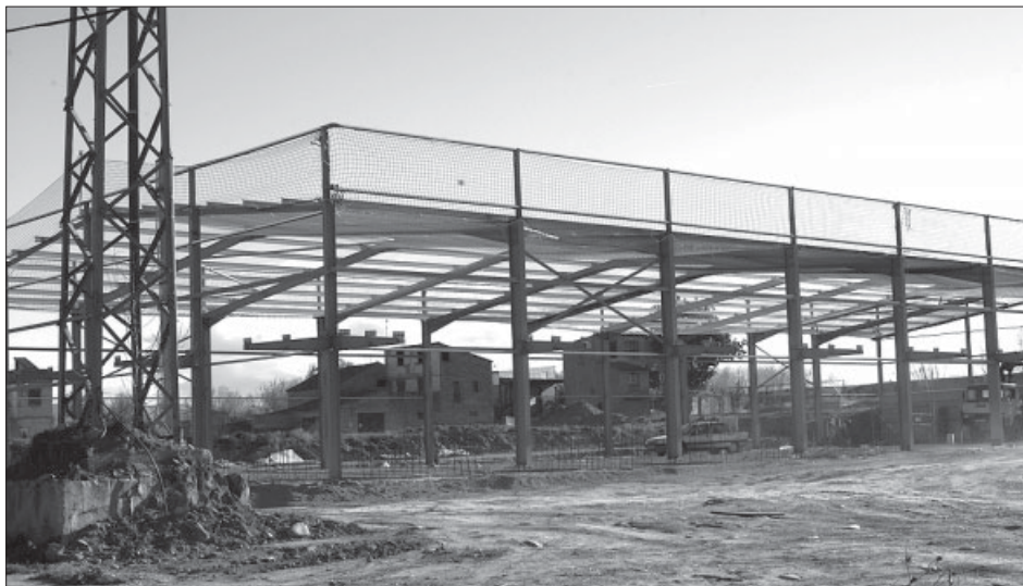
Les obres del nou pavelló continuen a bon ritme
