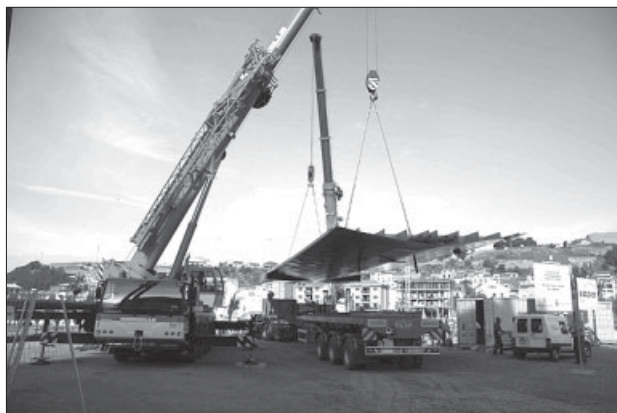
Camions de transport especial amb la passarel·la
