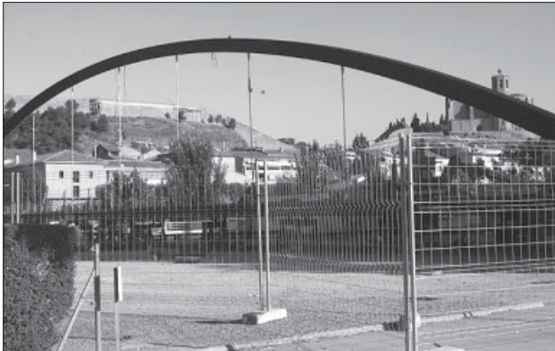
Passarel·la en construcció sobre el Segre
