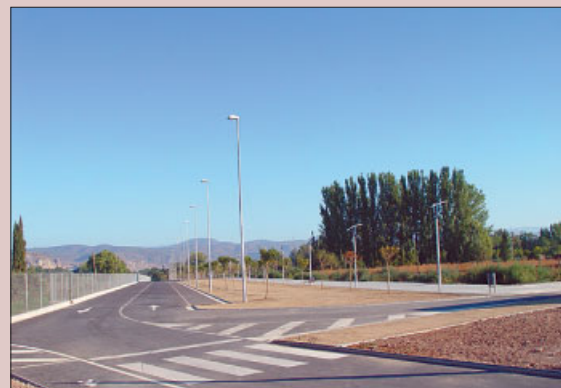
Nova zona de la carretera de Camarasa
