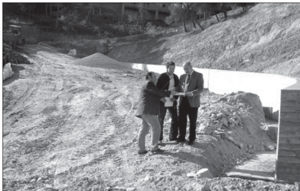
Visita d'obres al Centre Històric
