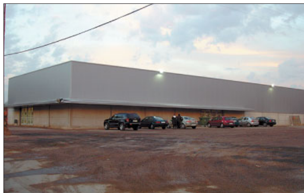
Vista exterior de la nova sala de Ball de Balaguer
