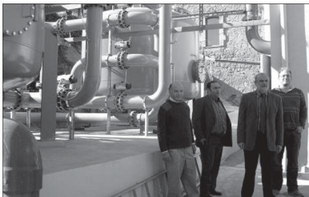
Un moment de la visita a la potabilitzadora
