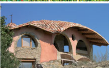
Coneixent materials per la bio construcció
