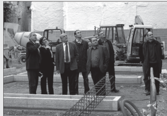
Oriol Nel-lo visita les obres del Centre Històric
