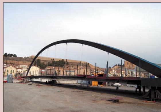
Passarel·la sobre el Segre
