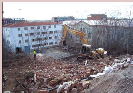
Obres d'enderroc del solar de l'Estel
