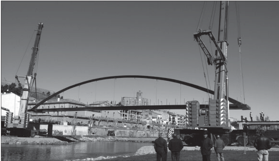
Col·locació de l'estructura de la passarel·la
