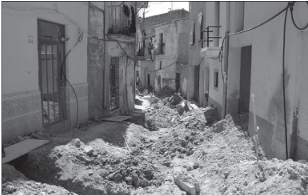
Urbanització del carrer Torrent
