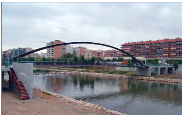
Nova passarel·la sobre el riu Segre
