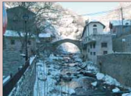
Pont de Tavascan a la Vall de Cardós
