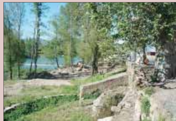
Obres de millora al riu Segre
