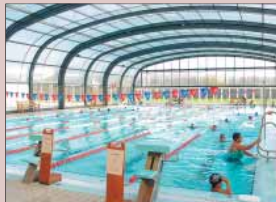
Piscina Coberta de Balaguer
