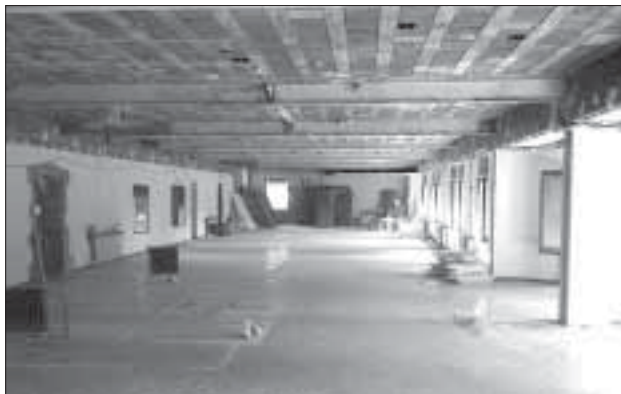
Estan acondicionant les instal·lacions
