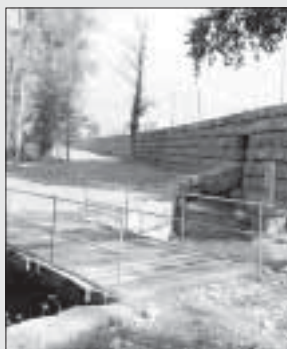
PORTADA Mur de contenció del riu Segre
