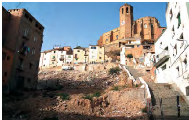
Les obres s'iniciaran durant aquest any
