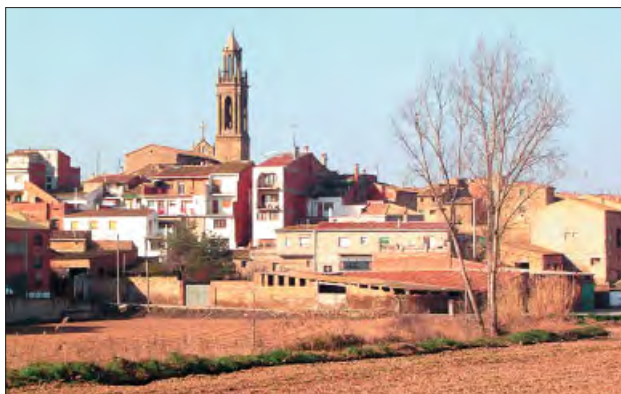
Montgai té una nova torre de telecomunicacions
