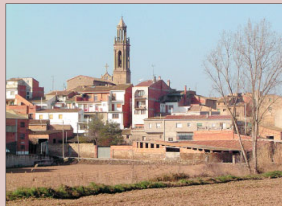
Nova torre de telecomunicacions a Montgai
