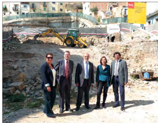
Inici de les obres dels nous Jutjats
