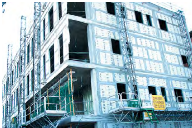
Obres del nou Hospital de proximitat
