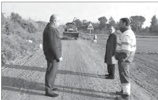
Visita d'obres en un dels camins
