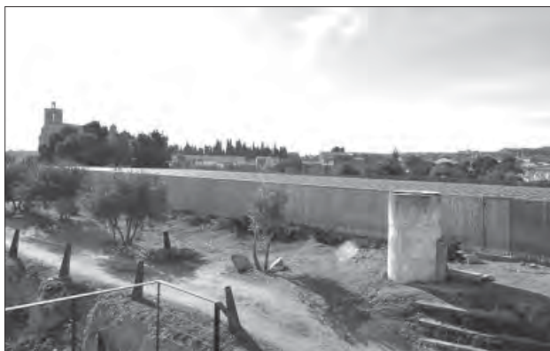
Obres de cobriment dels dipòsits
