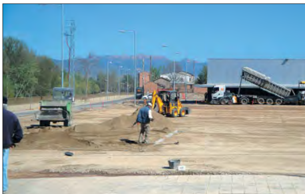
Adequació del parc del Molí de l'Esquerrà
