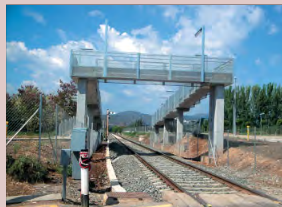
Pas elevat sobre la via del tren al Ctra de Camarasa
