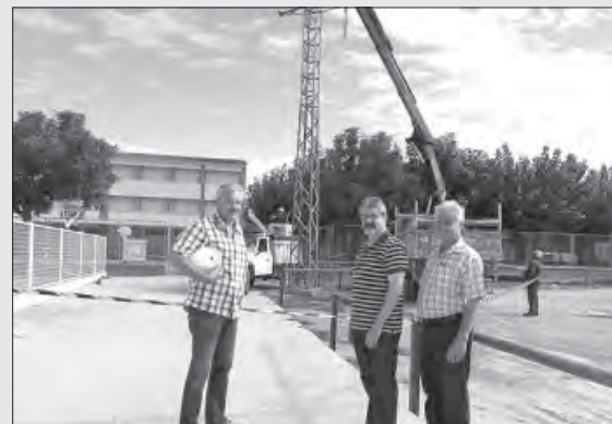
Roigé i Vendrell van visitar les obres del soterrament de línies d'Alta Tensió
