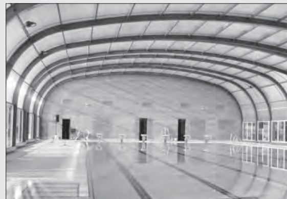
Piscina coberta de Balaguer
