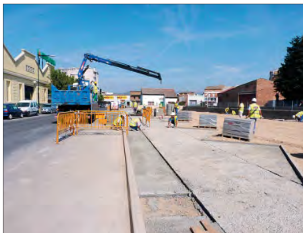
Obres del nou pàrquing
