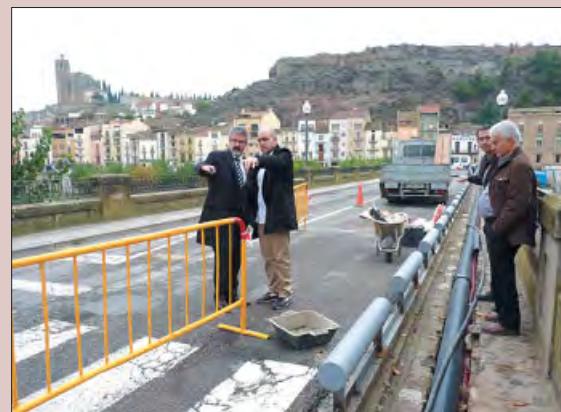
Millora de les instal·lacions al Pont
