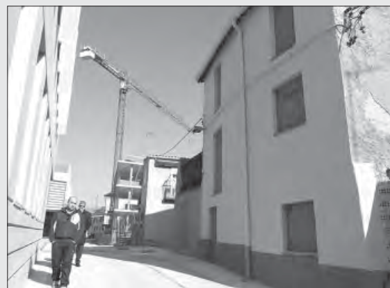
Una de les edificacions restaurades
