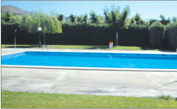
Piscines municipals d'Algerri
