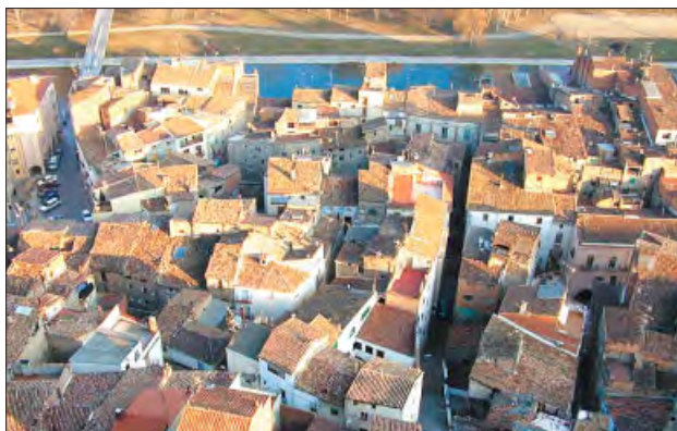
Façanes rehabilitades al casc antic de Balaguer
