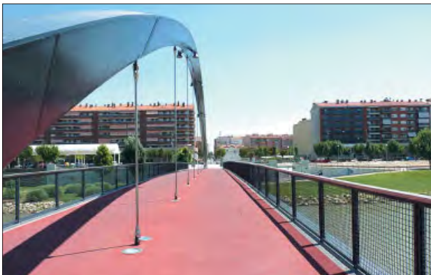
S'ha reparat el paviment de la nova passarel·la
