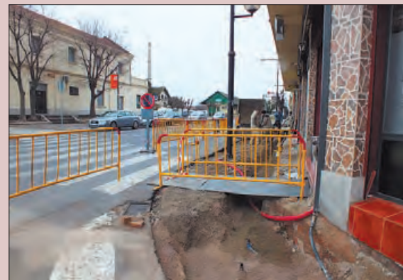
Obres al carrer Noguera Pallaresa
