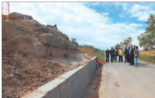
Visita a les obres al Pla d'Almatà
