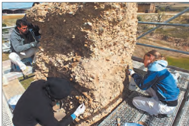
Obres de consolidació de la muralla
