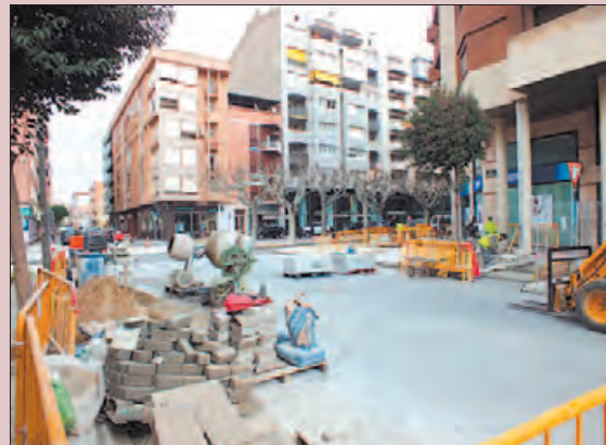
Obres al Passeig de l'Estació
