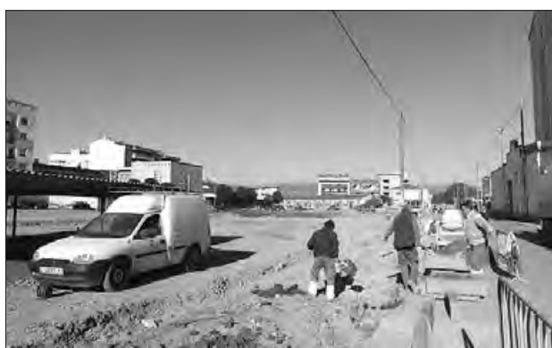
Obres del solar del carrer Les Escoles
