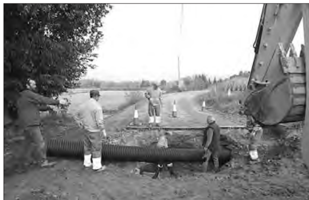
Obres al camí de l'Horta d'Amunt
