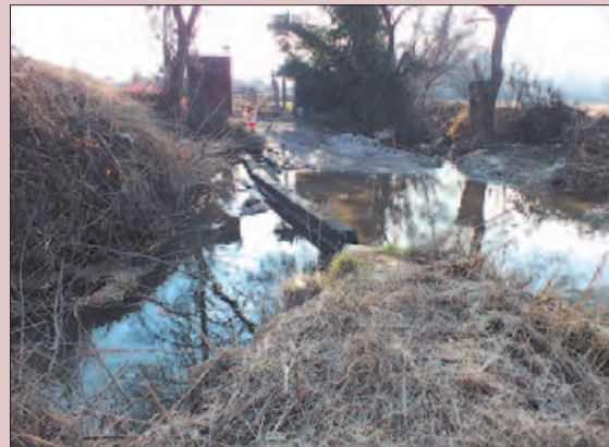
Obres al riu Sió
