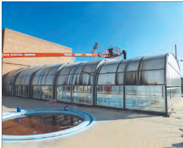
Reparació de la piscina
