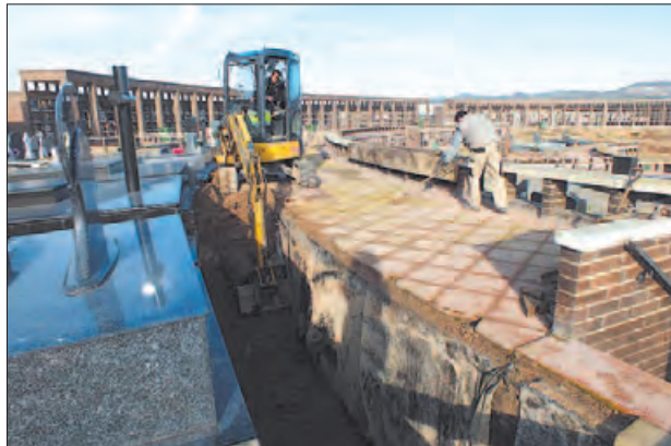
Obres al cementiri
